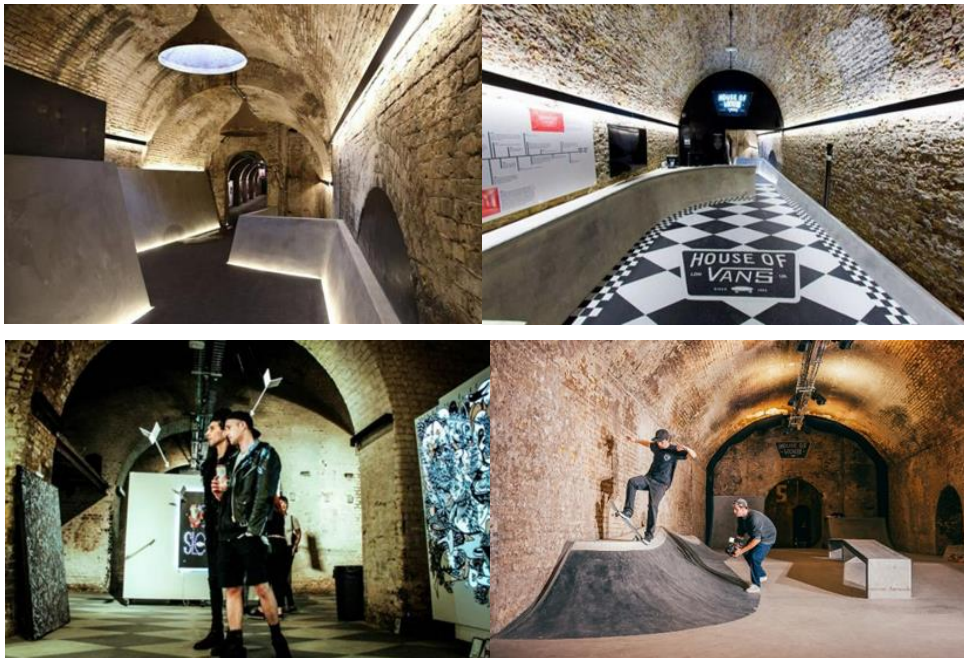
圖 3-3-3 滑鐵盧火車站隧道現況照片
